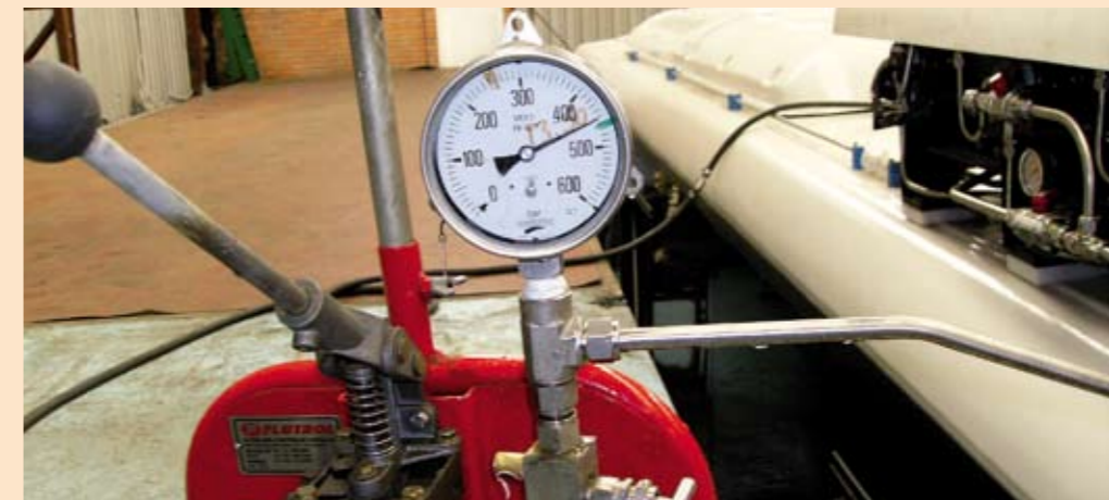
Teste hidrostático da tubulação de alta pressão.
